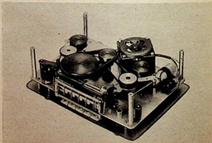
Bild 6. Untersicht des Thales-Tonbandchassis
