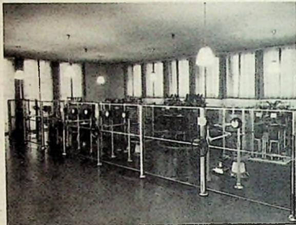
Bild 2. Seit mehr als 20 Jahren arbeitet diese alte Telefunken-Anlage als Hamburger Mittelwellensender
